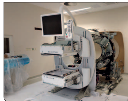
Montáž v plném proudu - SPECT gantry
